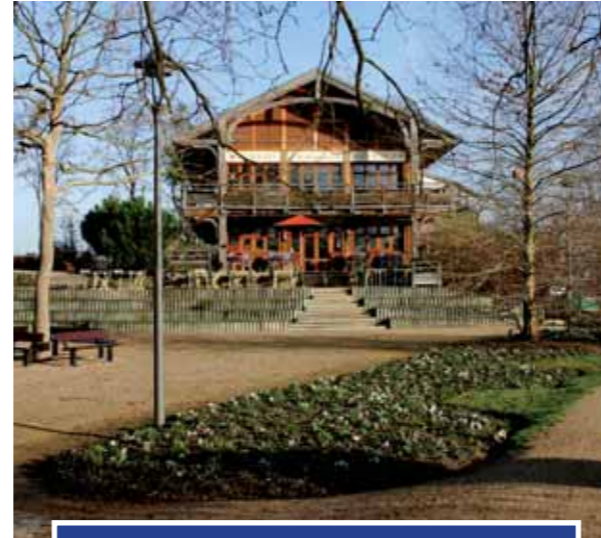
Aménagement du pôle Fournaise à Chatou. Participation du Conseil général : 90 000 € et 30 000 € pour la maison flottante (ateliers d'artistes).
