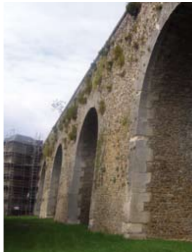
L'Aqueduc de Louveciennes en cours de restauration par l'État, grâce à Pierre Lequiller et Roger Cardon.
